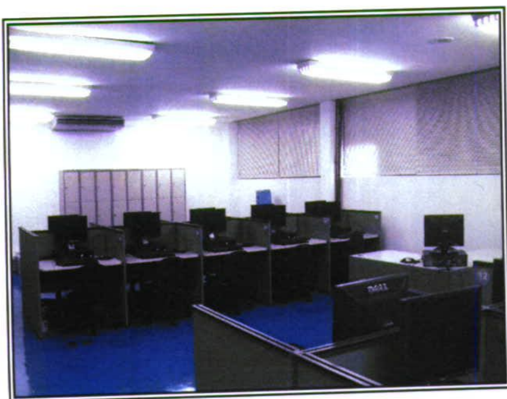
Supervisão/Central de Processamento de Dados
